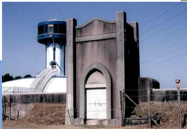
旧桃山一号配水池監視廊入口
